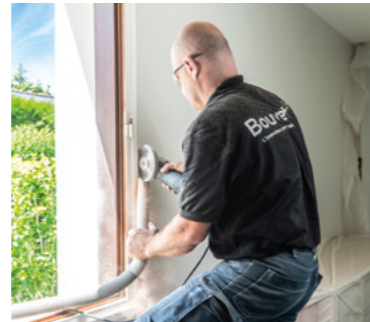
Suppression du dormant dans sa totalité
