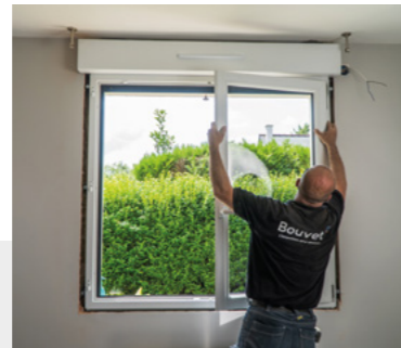
Mise en place des ouvrants
