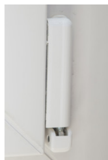
Paumelle pour oscillo-battant Pour fenêtre
