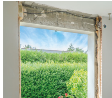
Vérification de la propreté des supports
