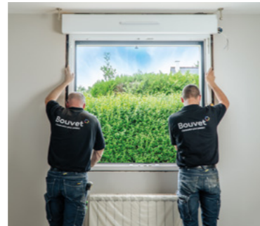
Présentation du dormant de la nouvelle menuiserie
