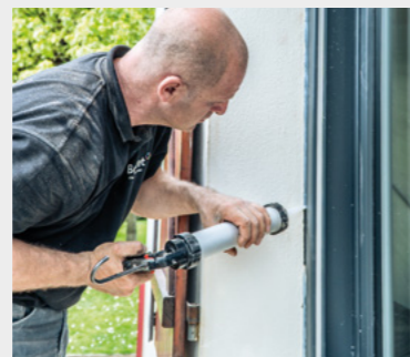
Pose des joints de finitions
